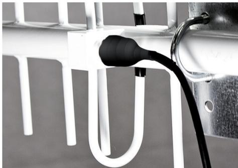
**Obs.:** prenda el cable coaxial al mástil con el auxilio de abrazaderas de plástico o cinta aislante.
