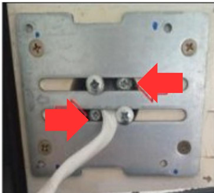
Os contra parafusos devem ficar dentro do furo para portas com espessura maior que 3,5cm e para portas com espessura menor que 3,5cm não devem ser utilizadas.
