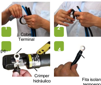
Conector de terra de proteção PDP (conectado ao ponto terra do gabinete)
