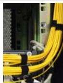
Não torça, dobre, estique ou comprima fibras ópticas durante a instalação. O raio de curvatura das fibras ópticas não deve ser inferior a 10 D.
