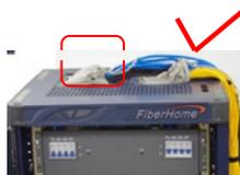
Instale proteções contra ratos na parte superior e inferior de um gabinete ou prenda bolsos à prova de mouse após o layout dos fios e cabos.
