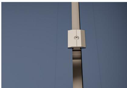
**Obs.:** o grampo intermediário e o grampo final atendem os módulos com altura de 30 a 40 mm e são dotados de engate rápido que permite o encaixe utilizando-se apenas uma mão, seguido de aperto.
